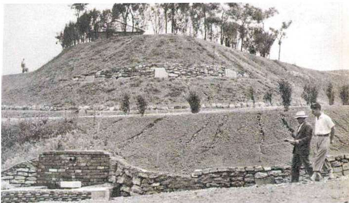
Il Monte Stella in costruzione
