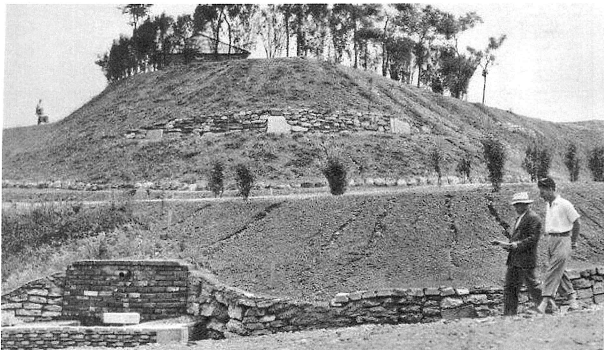
Il Monte Stella in costruzione
